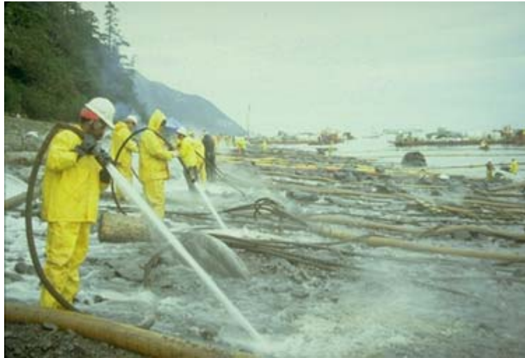
Pulizia della costa utilizzando getti di acqua calda
